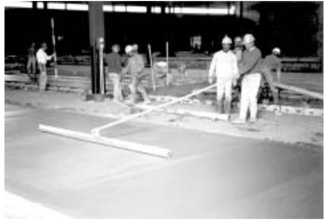
Fig. 8.6—“Modified highway” straightedge.
