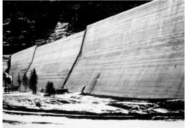
Fig. 1.3—Upper Stillwater Dam.
