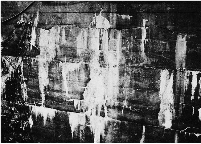
Fig. A.2.12—Efflorescence
