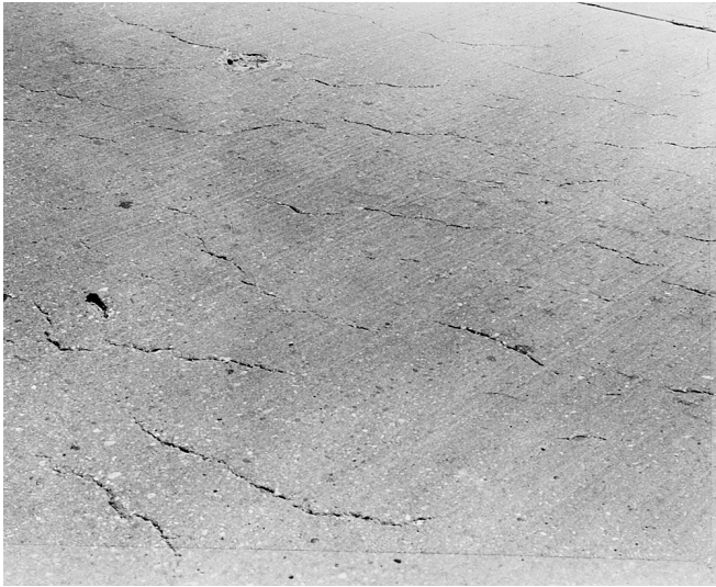
Fig. A.1.1—Checking
