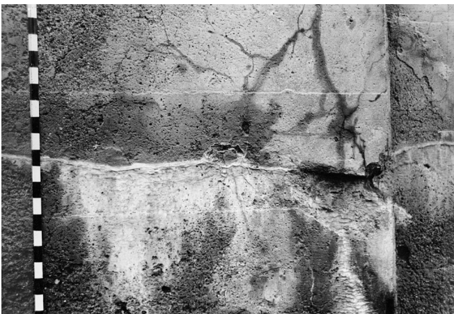
Fig. A.2.15—Erosion
