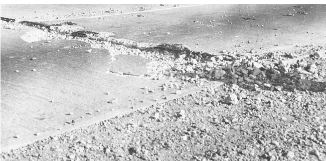
Fig. A.2—Disintegration
