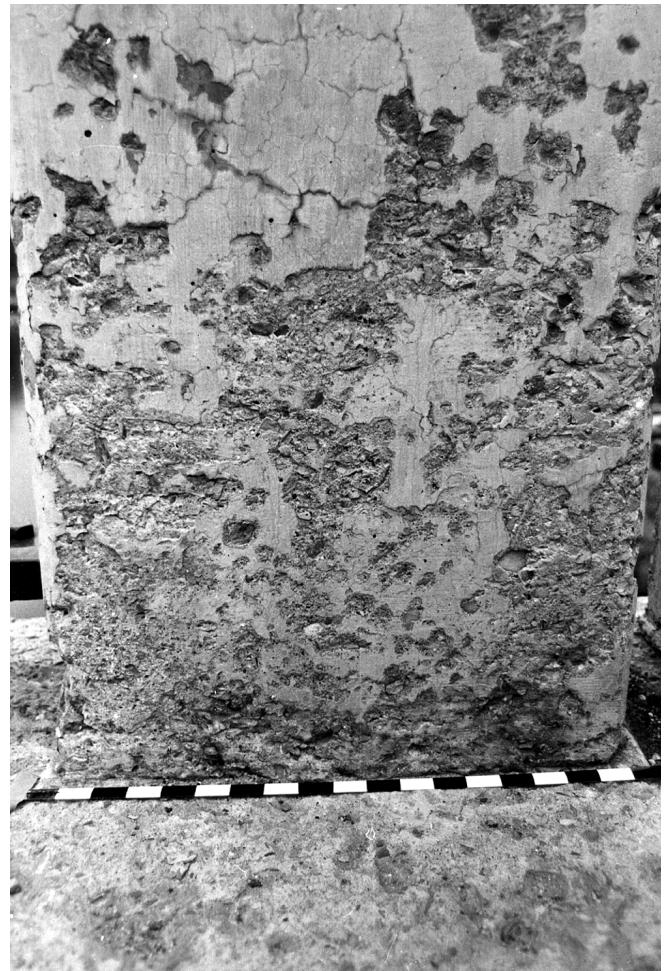
Fig. A.2.20.2a—Scaling (medium)
